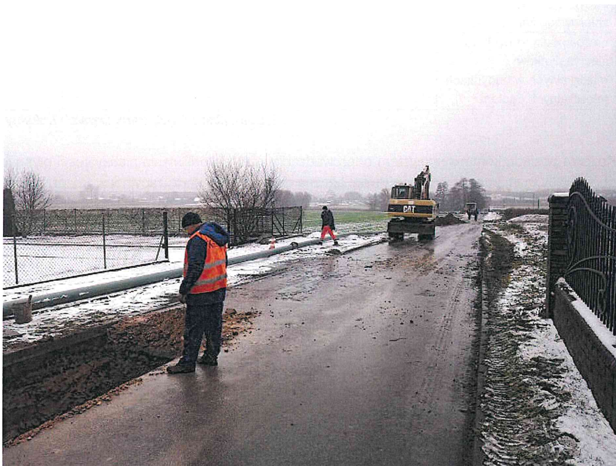
Zdjęcie: budowa kanalizacji w m. Rozprza
